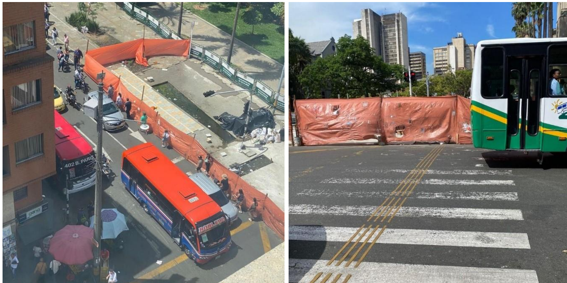
Imagen 23. Fotografías intersección Avenida de Greiff con Carrera Carabobo - Contrato 4600094538.
