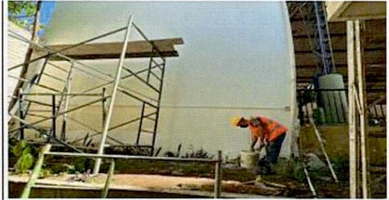
Foto No. 6 Aplicación de pintura
