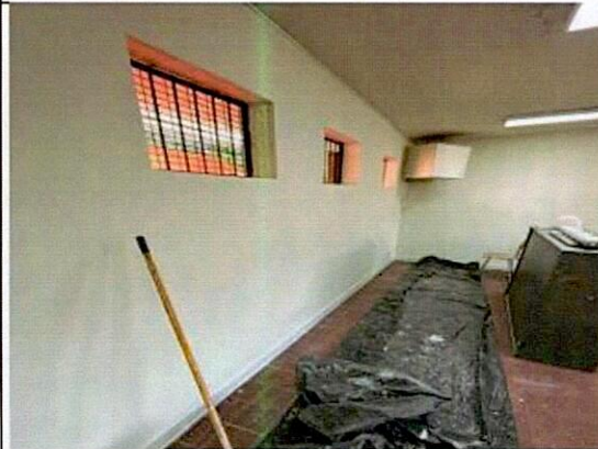
Foto No. 7 Aplicación de pintura
