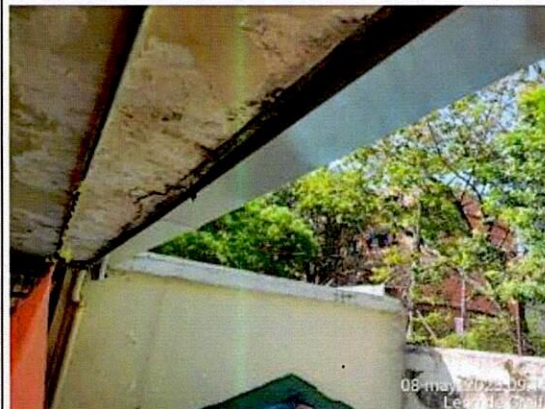
Foto No. 9 Instalación de canoas
