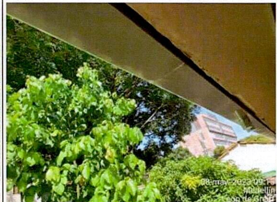
Foto No. 10 Instalación de canoas
