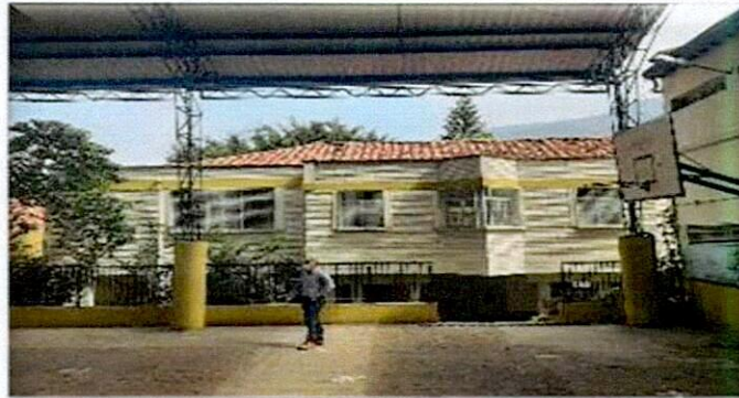
Ilustración 5 Estado inicial cancha
