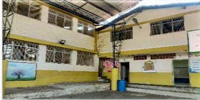
Ilustración 4 Estado inicial cancha
