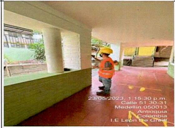
Foto No. 8 Aplicación de pintura
