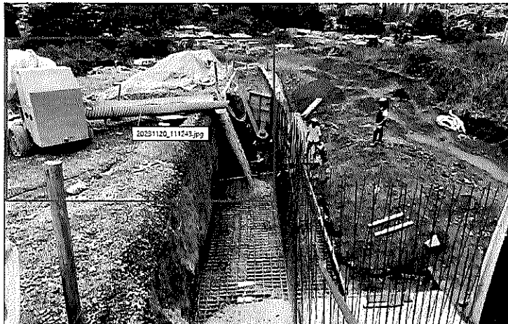
Registro de visita 20 de noviembre 2023
